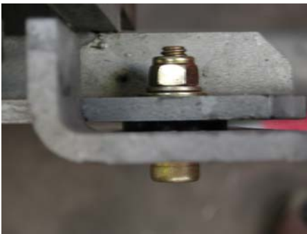
Colocación de las cuñas debajo de las guías de deslizamiento
